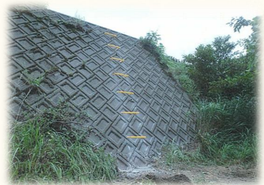
牧野内の昇降タラップ設置
