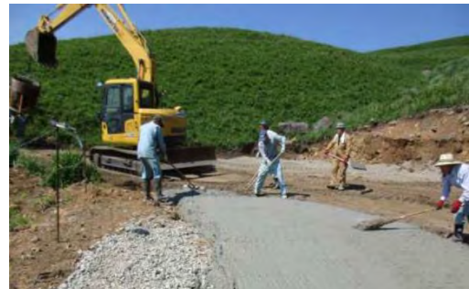
地震により損壊した管理道の修繕
