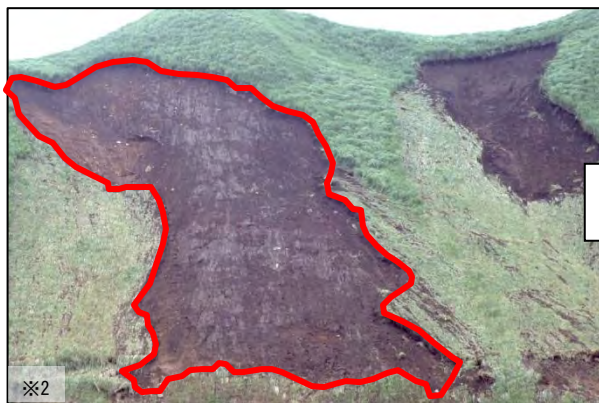
1990年豪雨による表層の崩落
