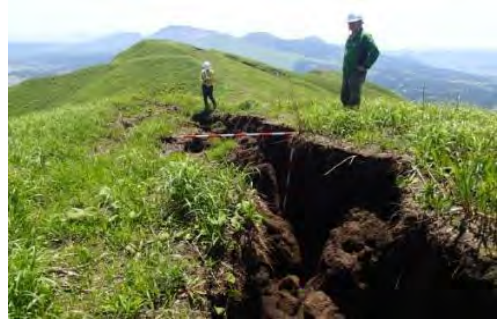
地震により発生した亀裂
