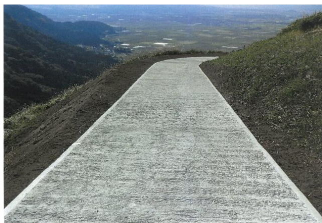
作業道 (コンクリ舗装)
