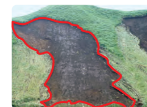
1990年豪雨による表層の崩落
